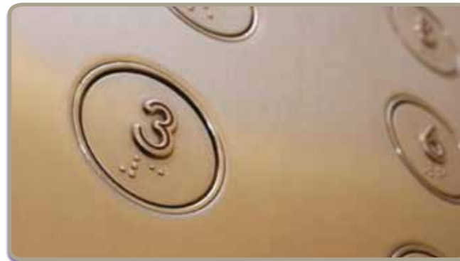
Şekil 11 - Dokunsal ve Braille sembolleri olan asansör kontrol paneli
