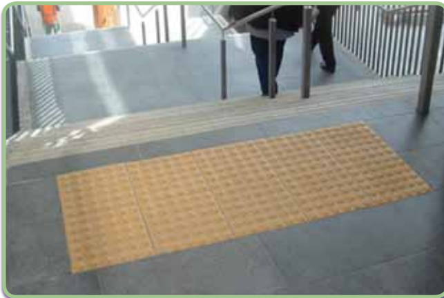
Şekil 8 - Seviyenin değiştiğini gösteren dokunsal yol bulma yüzeyi
